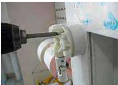
8) Pousser l'axe à l'opposé du treuil, rétracter l'embout d'axe, dévisser le treuil, puis retirer les flasques de l'axe.
